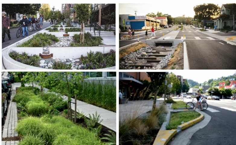
Slika 11. Zelene ulice - primeri bioretenzija u obliku mikro bazenčića, podignutih u okviru gradske ulične infrastrukture
